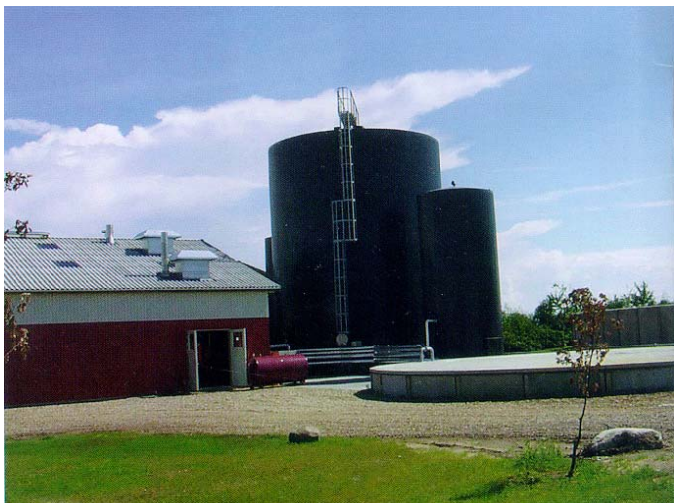
Figur 3.1. Billede af et biogasanlæg.
